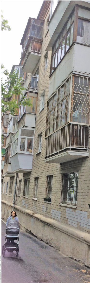
Жильцам этого дома на улице Фурманова придется затопориться, чтобы попытаться узаконить остекление балконов.
