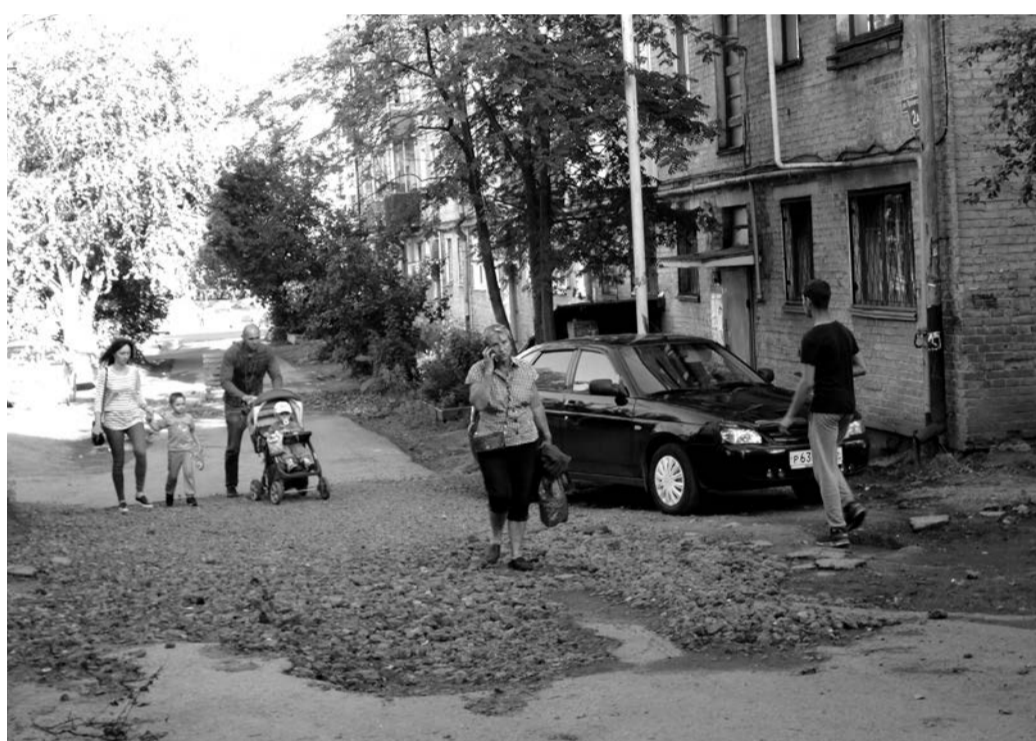
Засыпанная булыжниками яма на улице Пролетарской
