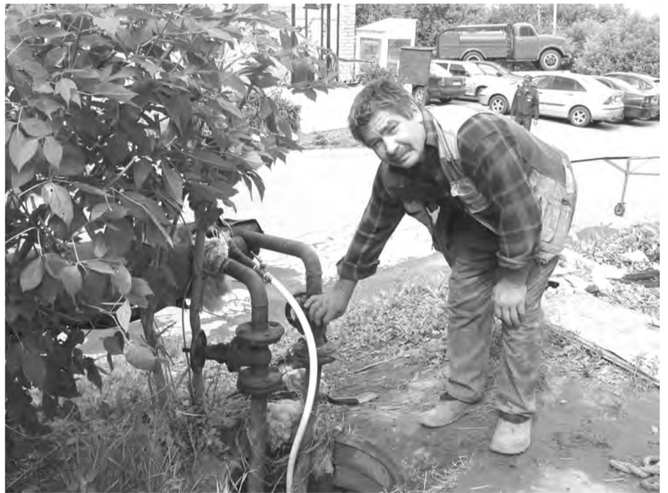
И через этот колодец пойдет новая труба - слесарь Вячеслав Кискин
