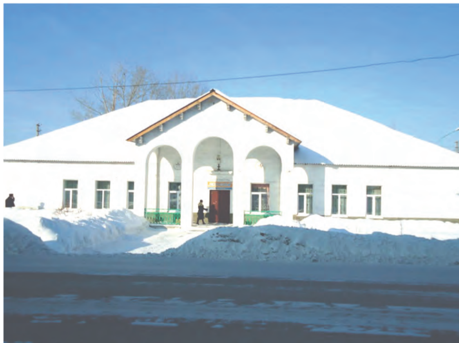
Дом культуры «Центральный», расположенный по ул. Ленина в пос.Троицком
