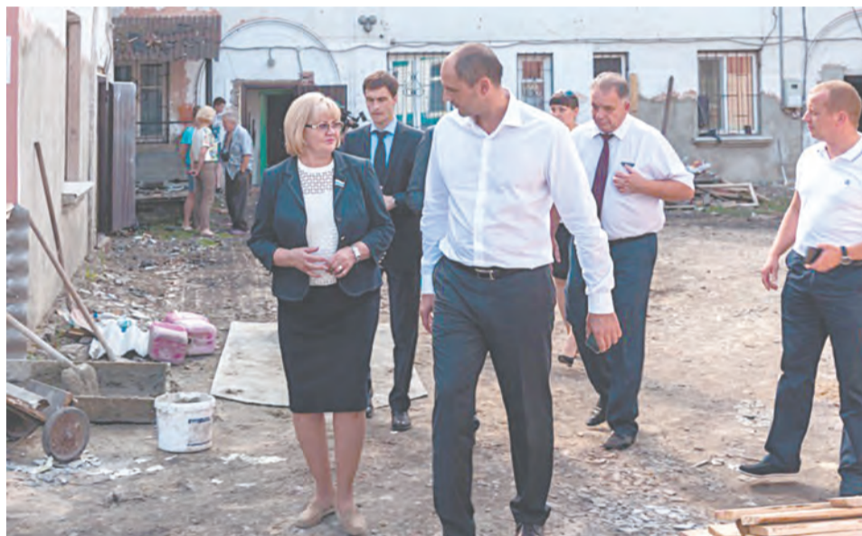
Капремонт порадовал. Жители тоже довольны
