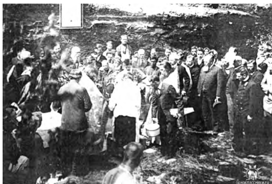
Начало строительства церкви святого пророка Ильи
