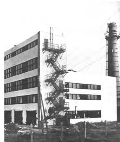
Котельная госплемзавода «Пионер». Фото из книги Г. М. Подоксенова и И. К. Черданцева. 1982 г.
