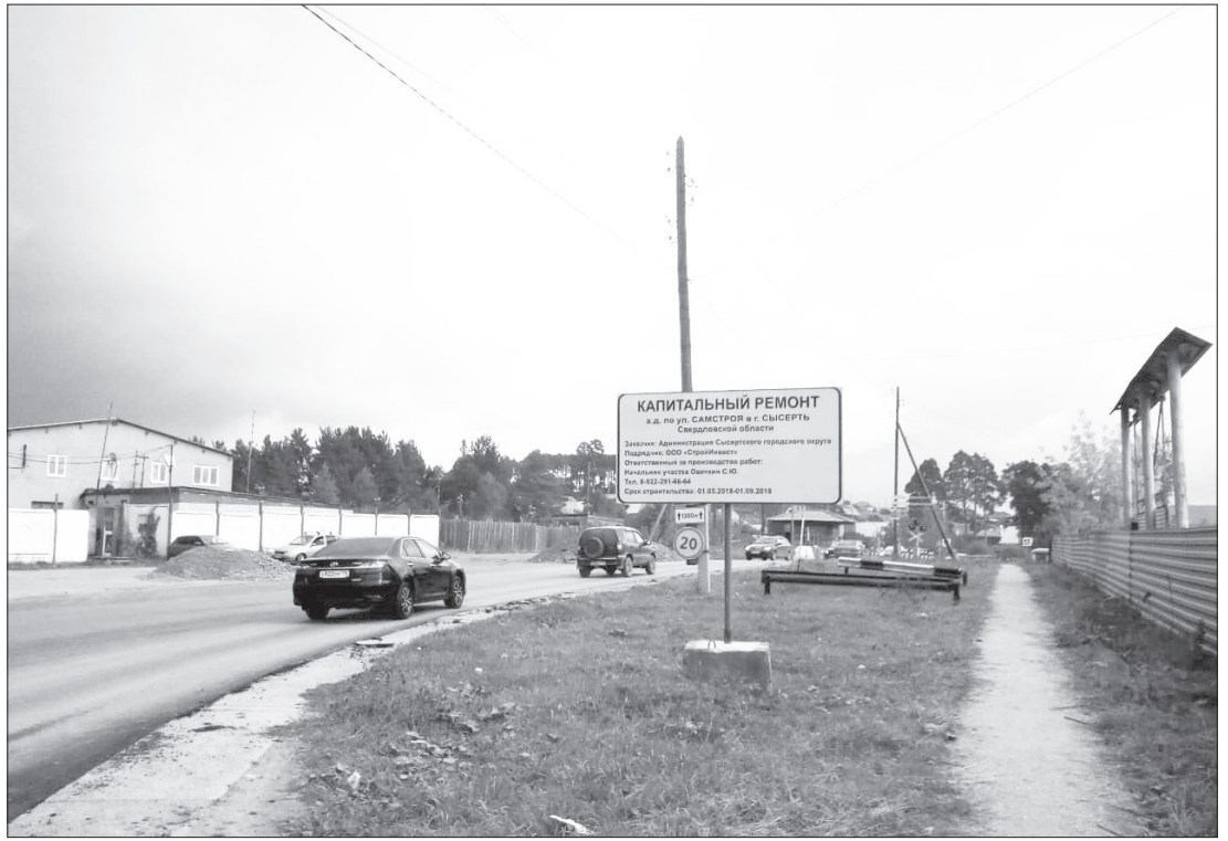
Ремонт на улице Самстрова близится к завершению
