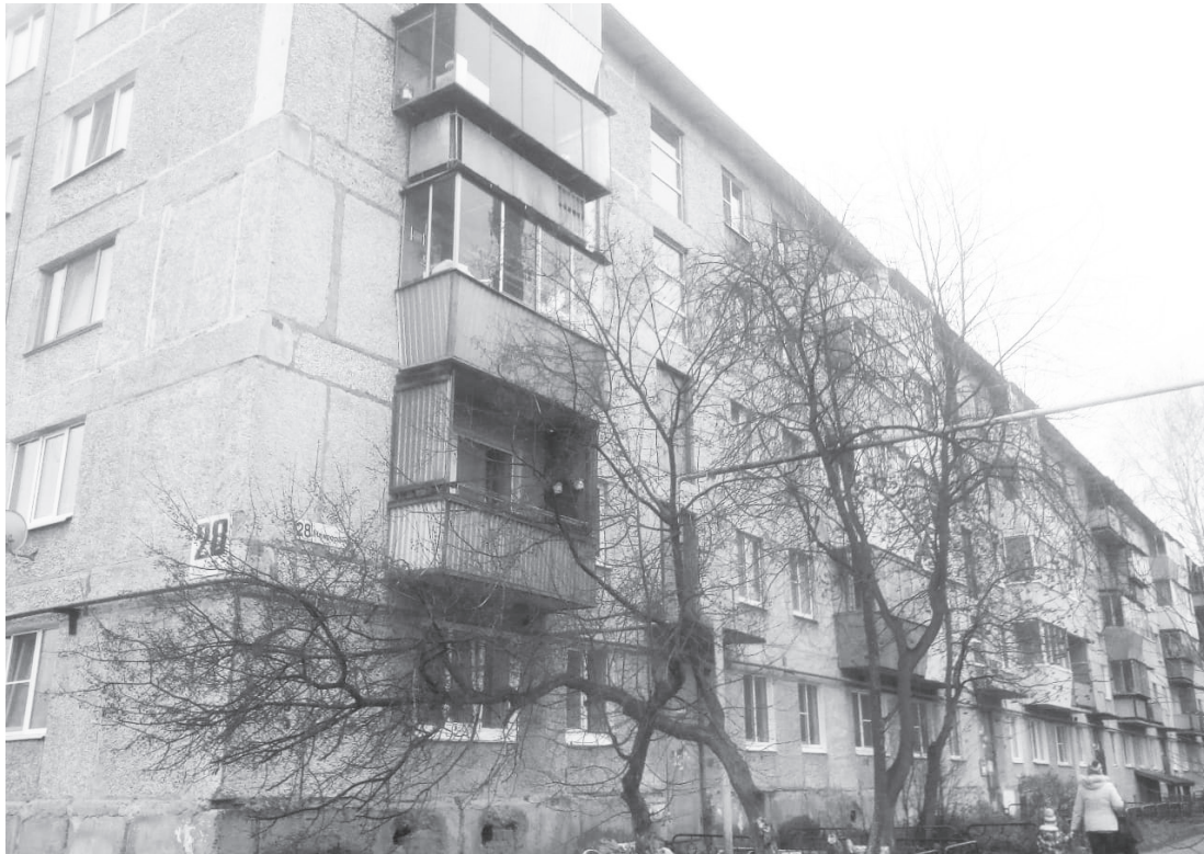
Единственный дом, от жильцов которого поступали жалобы на строителей в 2018 году из Сысертского округа - микрорайон Новый, дом 28. Здесь ремонт кровли привел к ремонту квартир пятых этажей уже самими жильцами за свой счет.
