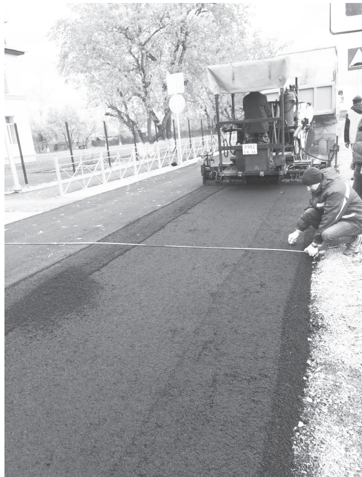
Ремонт дороги в Щелкуне
