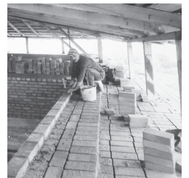
Кладка кирпичей на барабане купола
