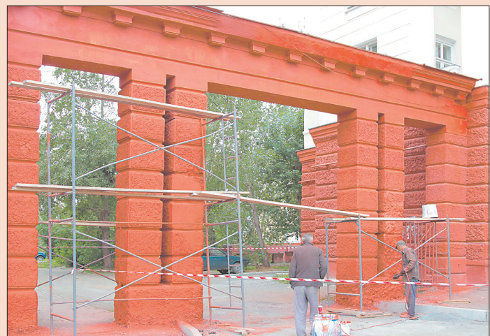
* Ремонт арочных входов на пр. Ленина ведет ООО «Управление».
