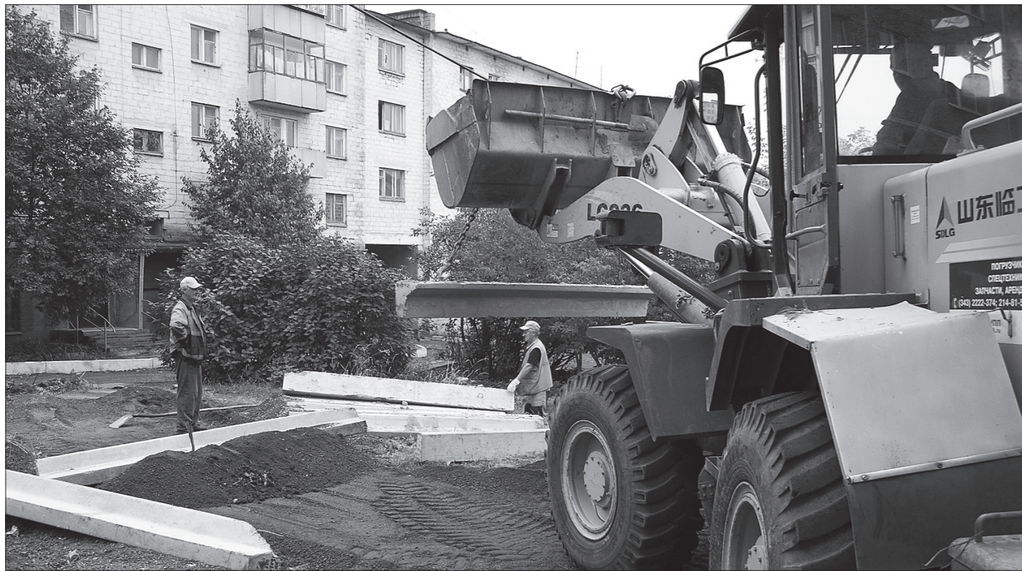
* Идет реконструкция двора.
