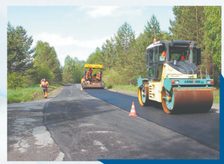
В 2010 г. введено в эксплуатацию 4,5 км. дорог со стороны Южного въезда в город. В 2011 г. начат ремонт проспектов Мира, Октябрьский и Вагонстроителей. До 2014 г. в ремонт дорог будет вложено 1 млрд.рублей из областного бюджета.
