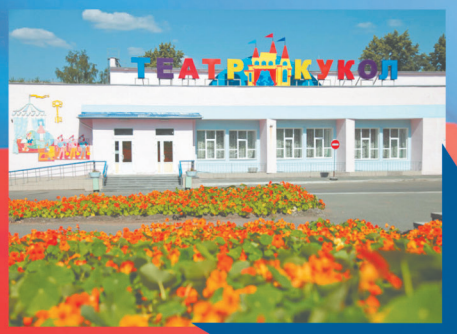
Отремонтирован фасад и кровля здания Нижнетагильского театра кукол, на очереди ремонт ДК «Юбилейный».
