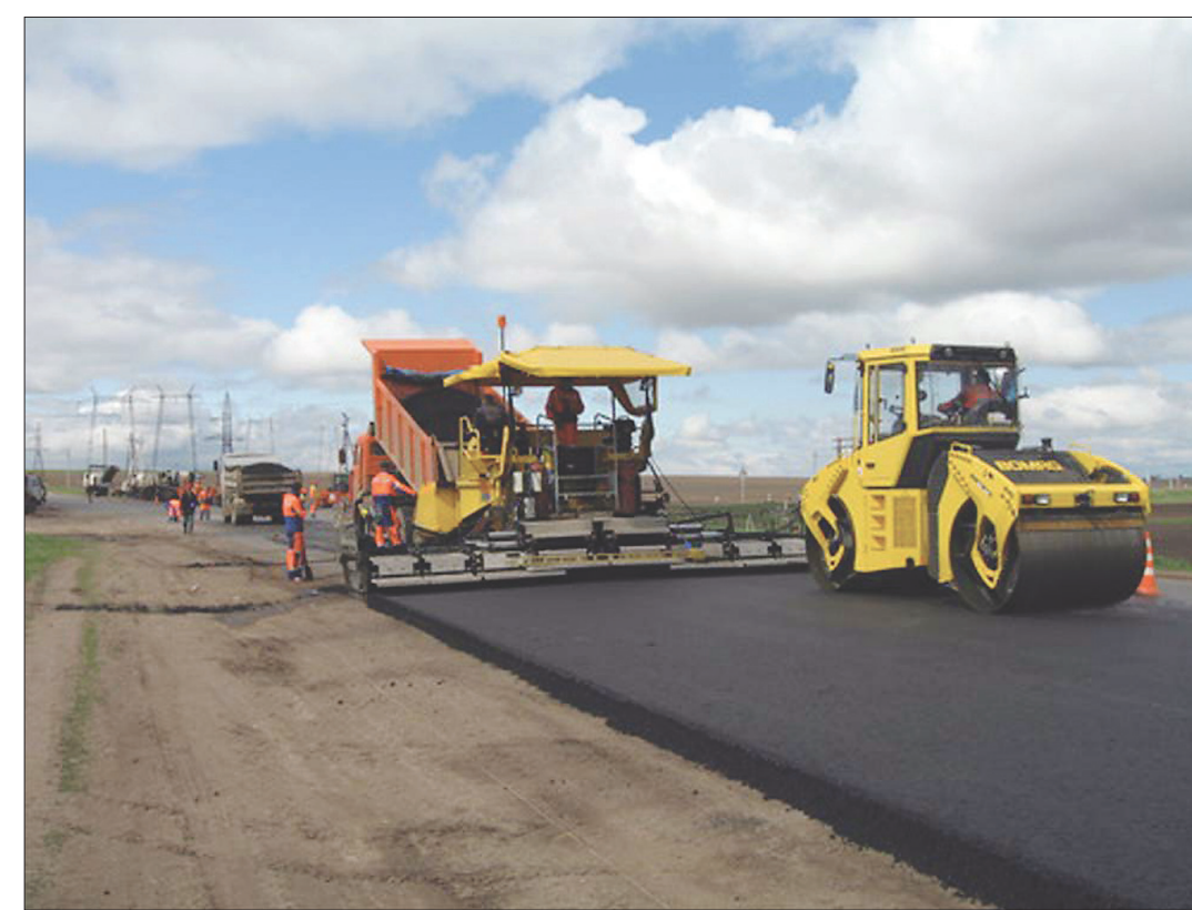
* Строится новая дорога.
