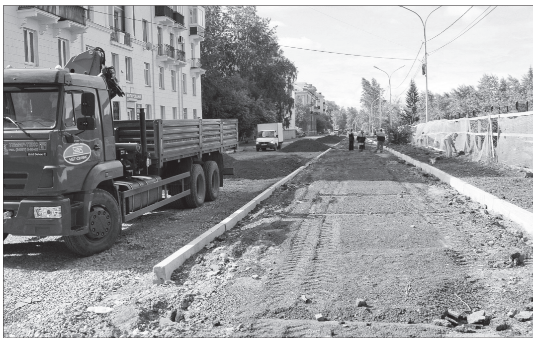
Идут работы на улице Окунева. ФОТО НИКОЛАЯ АНТОНОВА.
