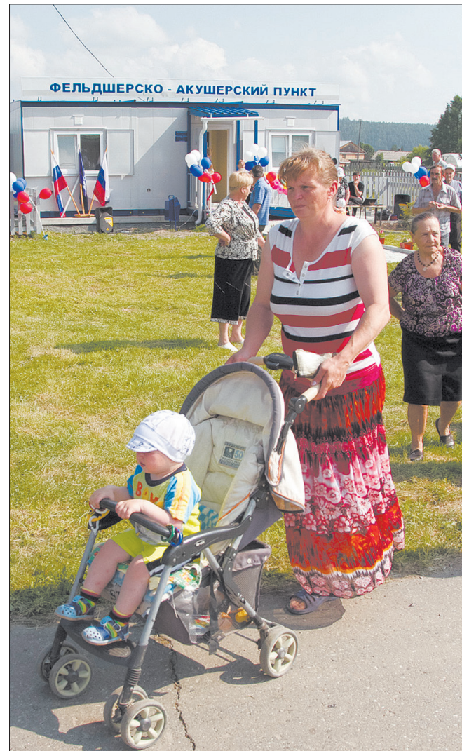
Здание ФАПа – в центре Усть-Утки, рядом со школой и местной администрацией.
