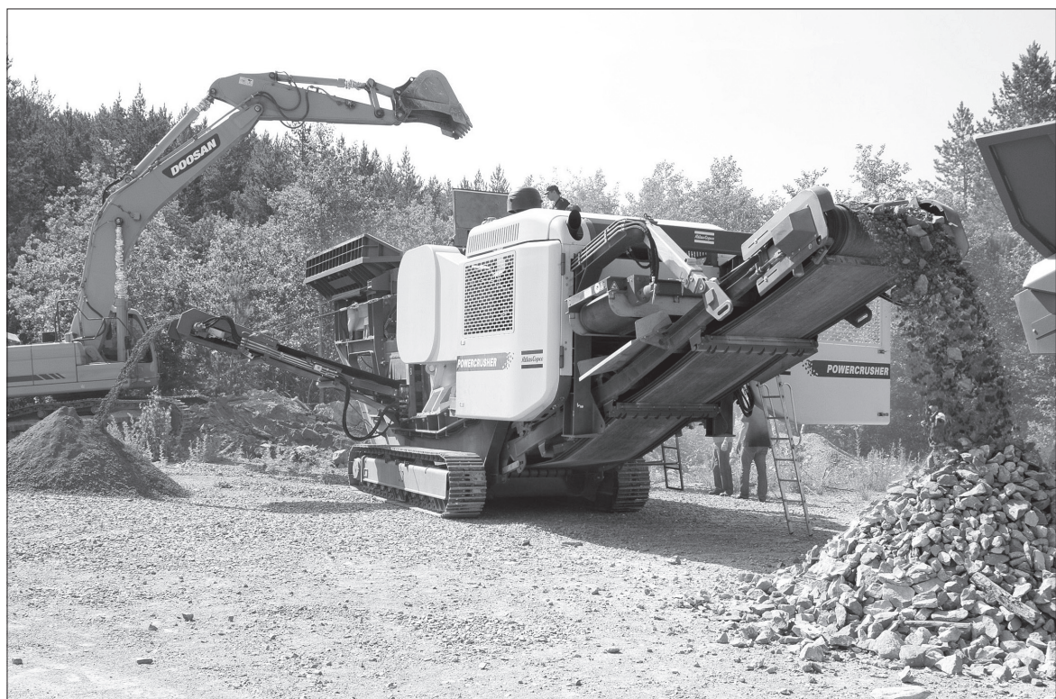
Идет тестовый запуск оборудования.
