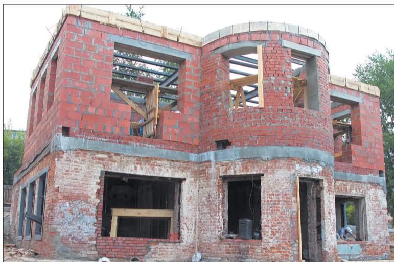
Хорошо виден цокольный этаж с родной кирпичной кладкой.
