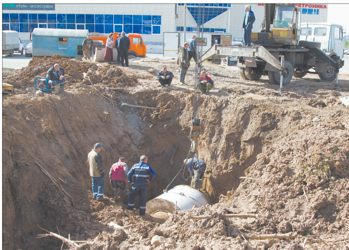
Специалисты Водоканала устраняют аварию. ФОТО СЕРГЕЯ КАЗАНЦЕВА.
