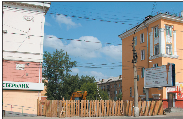
Со стороны дороги стройка смотрится беспроblemно.
