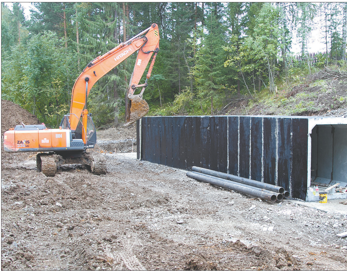
Инженерные сооружения трассы.
