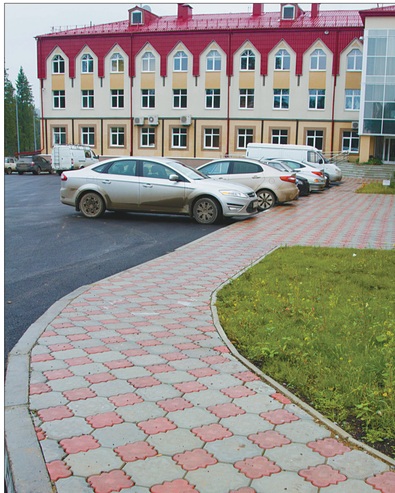
Пешеходные дорожки выложены тротуарной плиткой.
