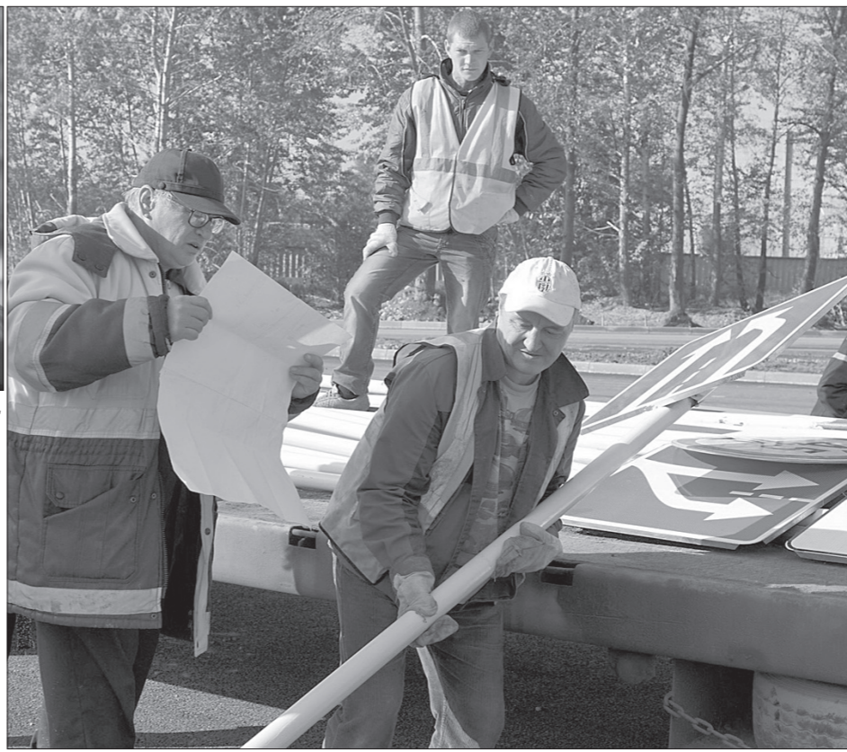
Евгений Гусельников руководит монтажом дорожных знаков.
