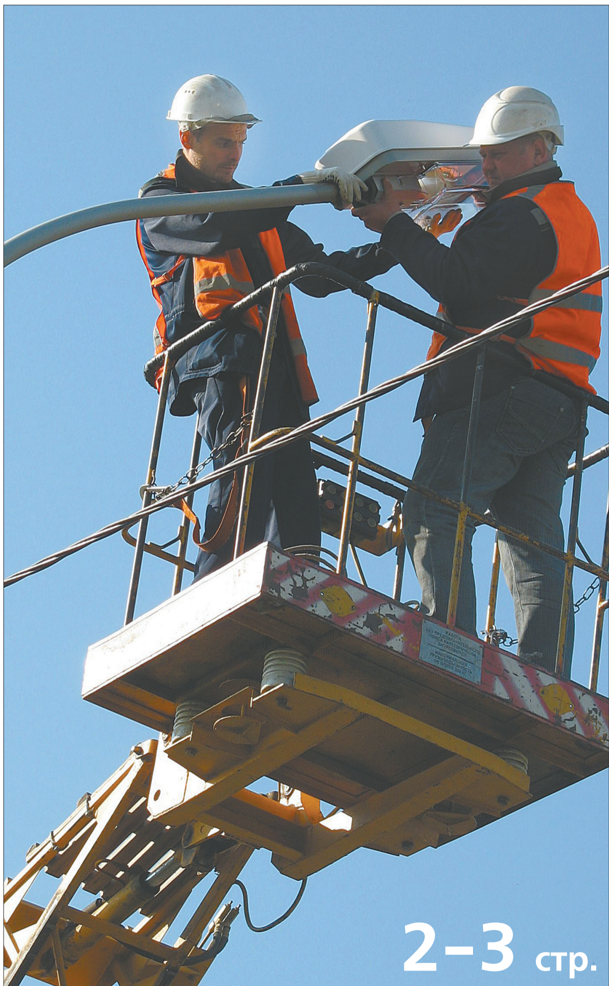
Монтаж новых светильников. ФОТО ИЗ АРХИВА ЗАО «ТАГИЛЭНЕРГОСЕТИ».
