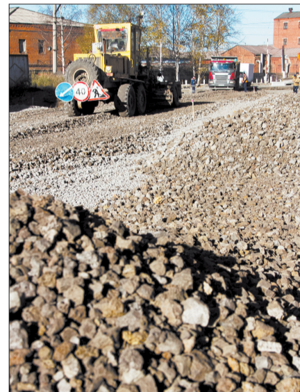
«Подушка» для будущего асфальта.
