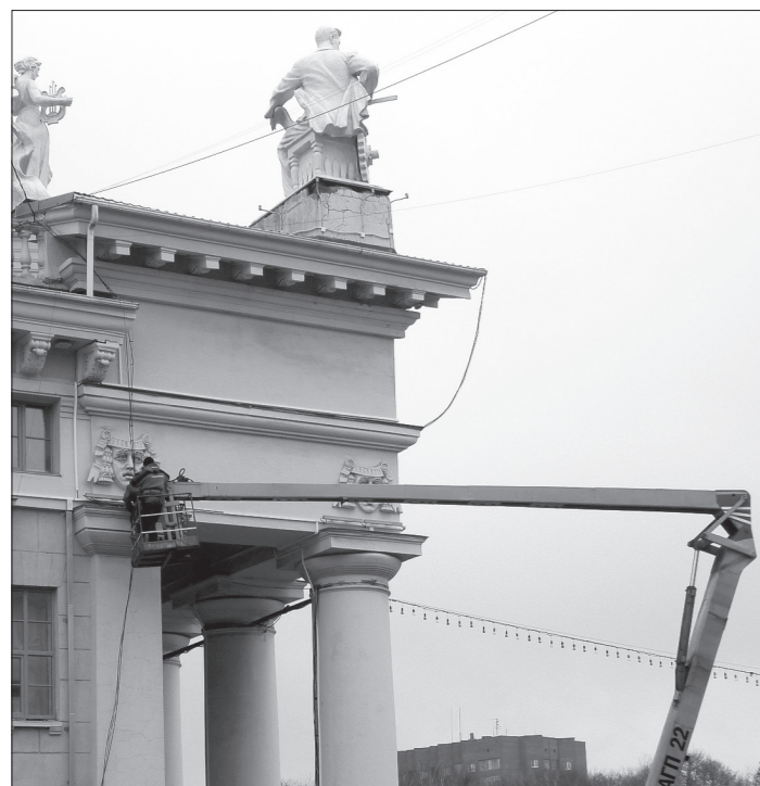
Идут монтажные работы.
