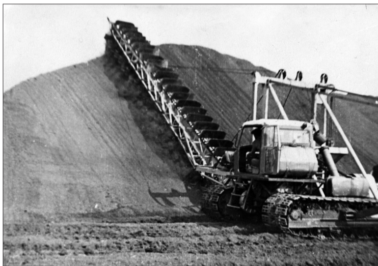
Окараванивание торфа машиной ОФ.
