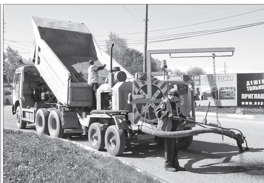
Заделка трещин в дорожном покрытии на улице Челюскинцев.
