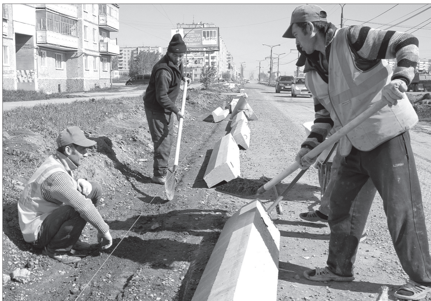
Идет установка бортового камня на Уральском проспекте. ФОТО НИКОЛАЯ АНТОНОВА.
