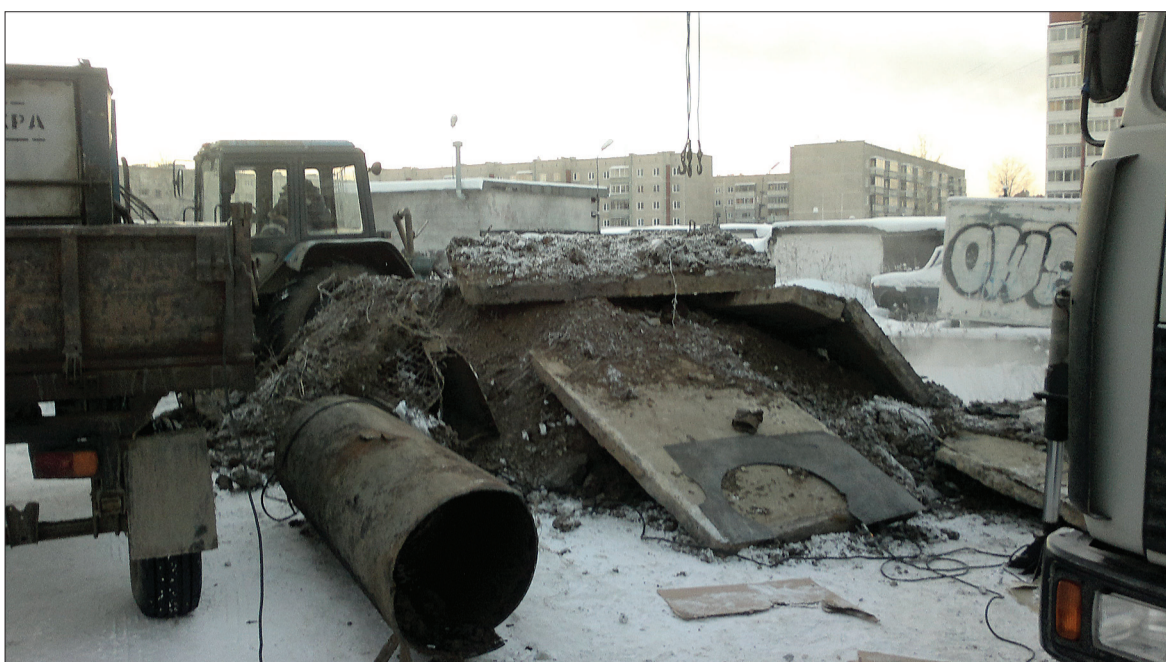
Аварийные работы 1 января...
