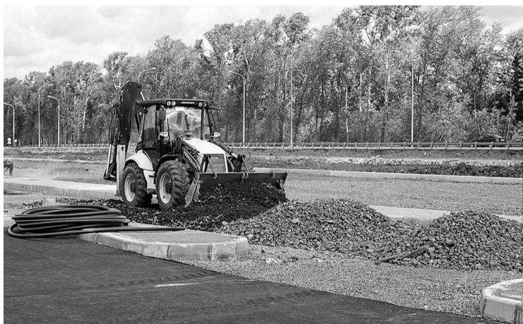
Строительство парковки у DEPO.
