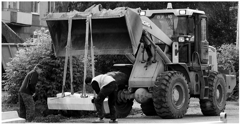
На Красноармейской укладывают бордюры. ФОТО АВТОРА.
