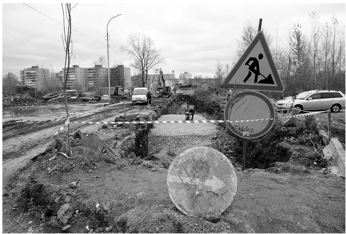
Строительство дороги к мосту-дублеру.
