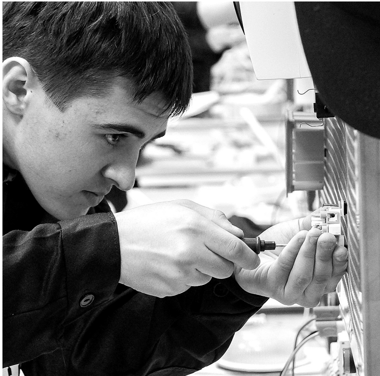
Евгений Слесарев монтирует электропроводку.
