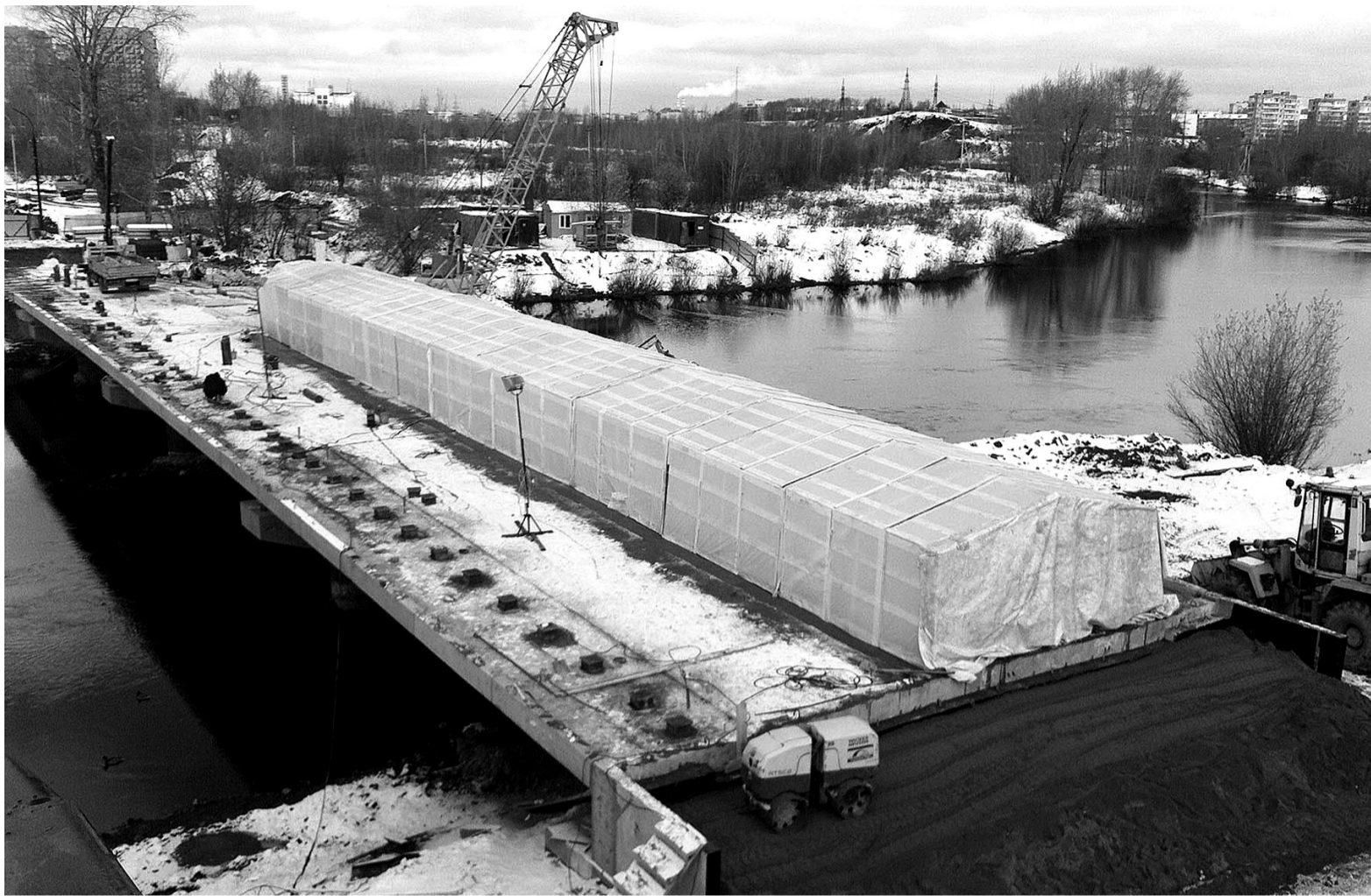
Из-за погодных условий на временном мосту пришлось построить саркофаг. ФОТО СЕРГЕЯ КАЗАНЦЕВА.
