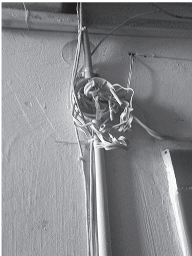
Оригинальный способ укладки сети.
