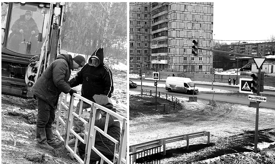
Идет установка ограждения по улице Красноармейской.
