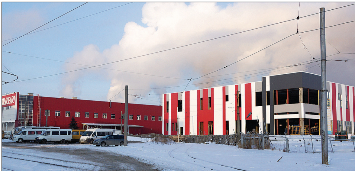
Строители скоро перейдут к внутренней отделке.
