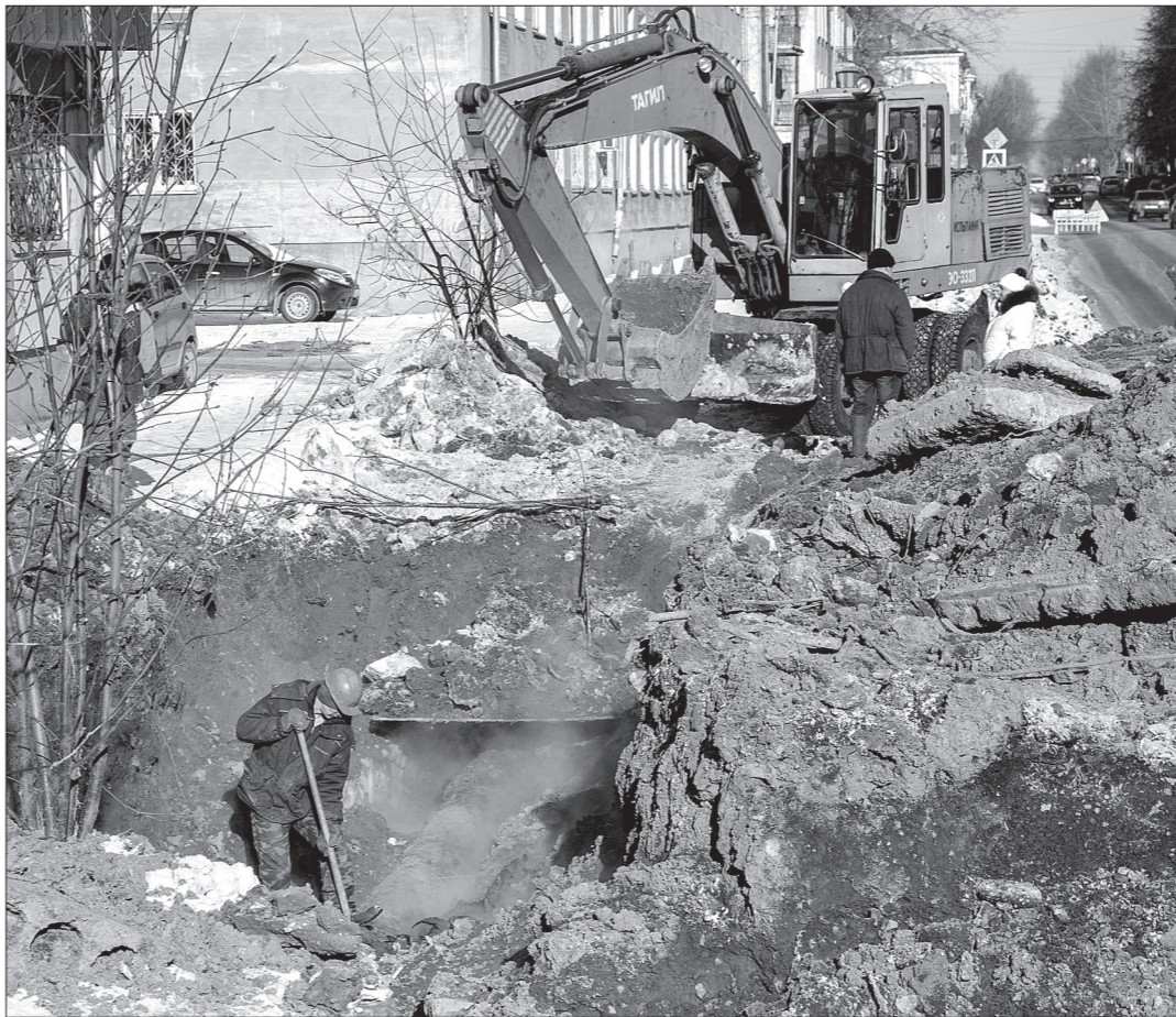
На аварийном участке будут менять трубу.
