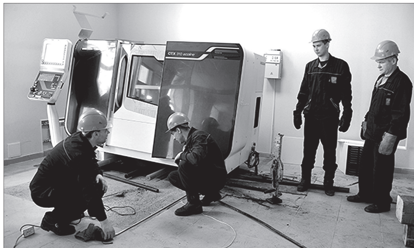
Монтаж токарного станка с ПУ. ФОТО ПРЕСС-СЛУЖБЫ ОАО «НПК УРАЛВАГОНЗАВОДА».
