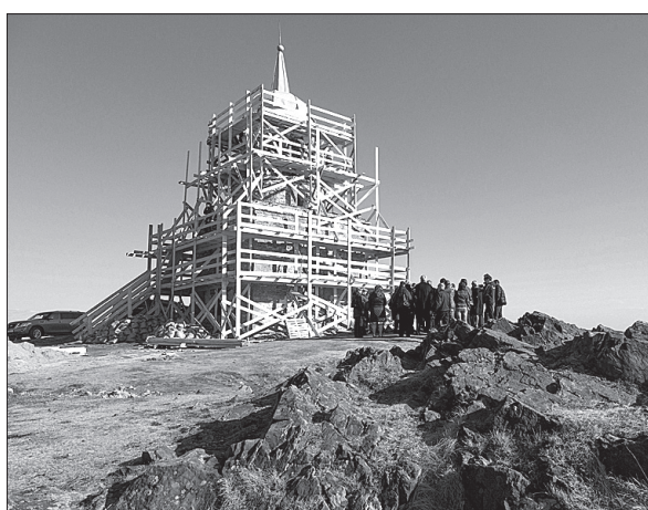
Специалисты сняли штукатурку со стен снаружи и внутри башни.
