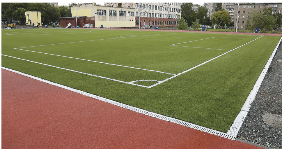
Строющийся стадион школ №50 и 33.
