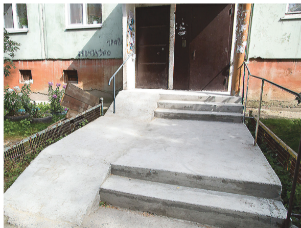
Соседям повезло больше: ремонт крыльца у них был.
