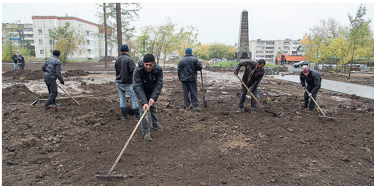
На газонах разравнивают плодородный грунт.
