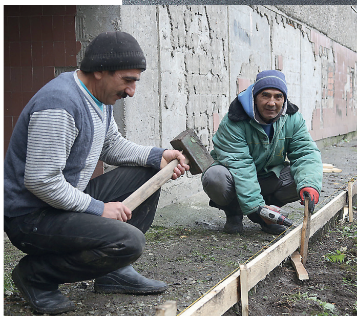
Отмостку дома тоже можно отремонтировать по программе.
