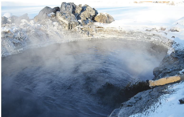
В щебеночную «ванну» закачивается жидкий шлам.
