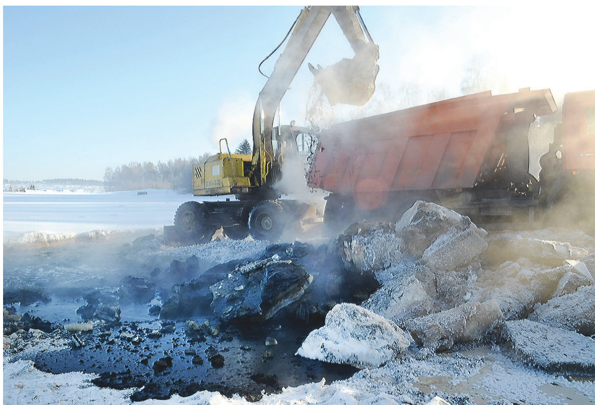
Чистка шлама экскаватором.
