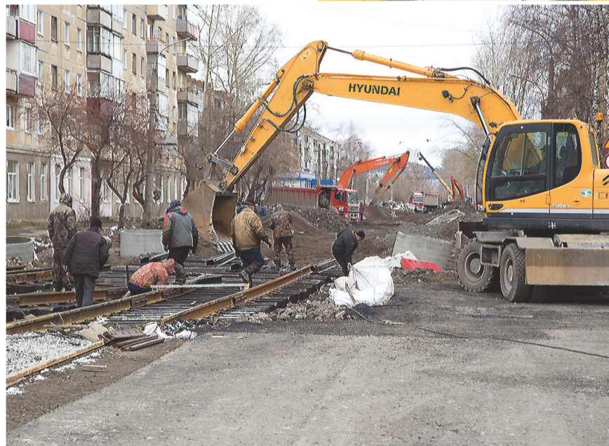
Работы на участке за перекрестком с Фрунзе продолжаются.
