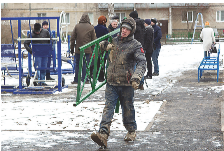
Подрядчики завершают монтаж ограждений.
