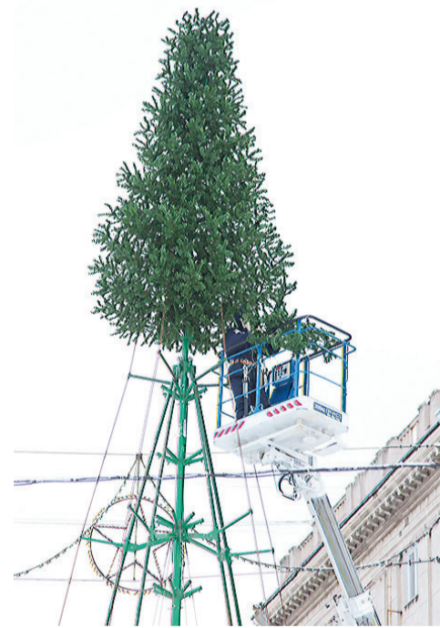
Монтаж главной елки.
