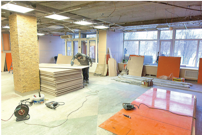
Идет монтаж стеновых панелей.
