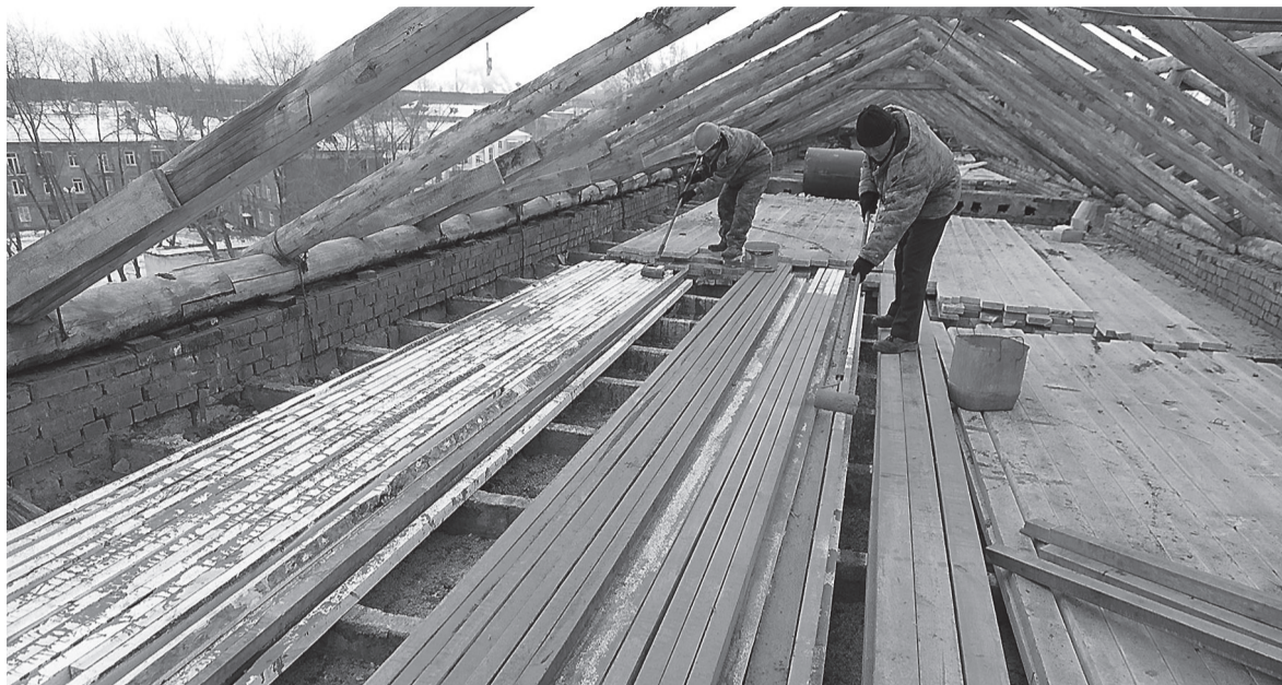
Большие силы брошены на ремонт кровли.
