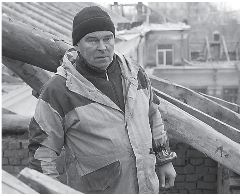
Мастер строительно-монтажных работ Сергей Кузнецов.
