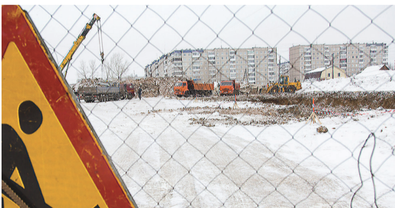
К концу следующего года здесь вырастет восьмиэтажка.
