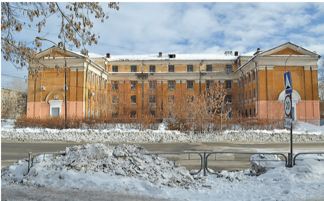
Школа №56 закрыта и ждет ремонта.
