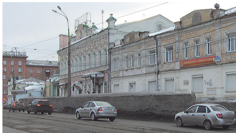
Подпорная стена будет отремонтирована.
