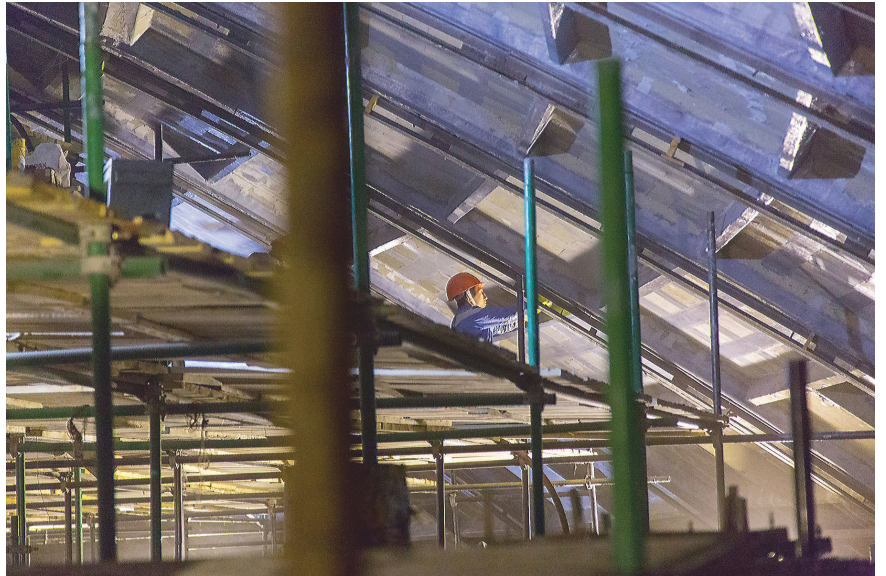
В мае строители завершат реконструкцию купола и приступят к оформлению зрительного зала.
