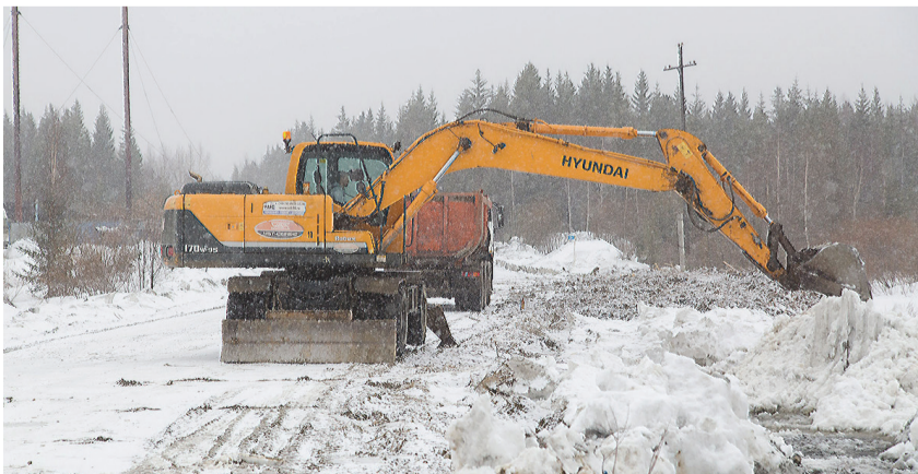
Экскаватор прочищает стоки.
